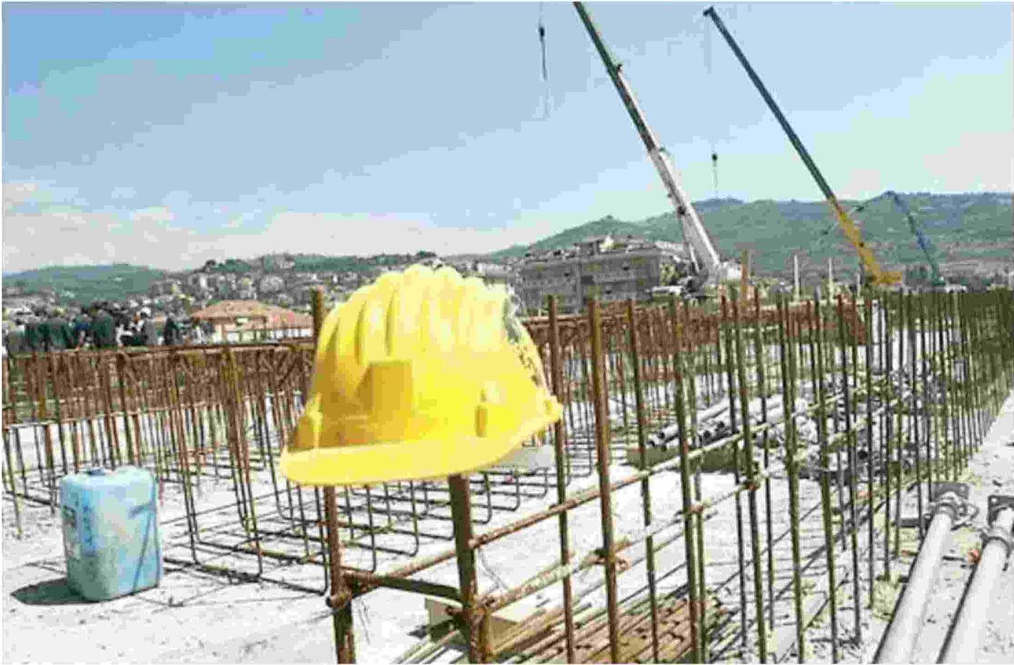
Un cantiere edile (foto di archivio)
