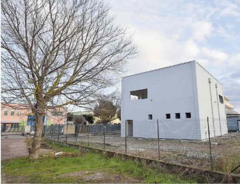
Il cantiere dell'Accademia Tecnologica Edilizia in via Siria (FOTO AGENZIA BF)
