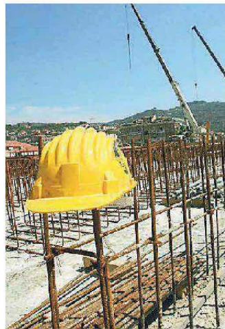
Un cantiere edile (foto Zennaro)
