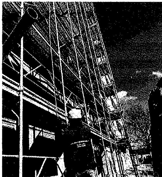
Un cantiere edile (foto d'archivio)
